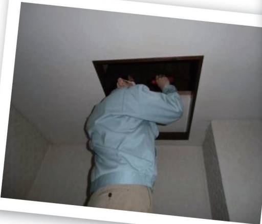
天井・小屋組み
