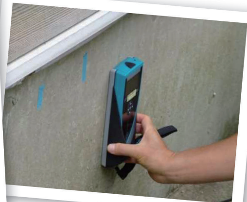
基礎（鉄筋探査）
