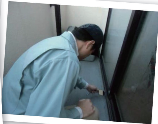
バルコニーの防水
