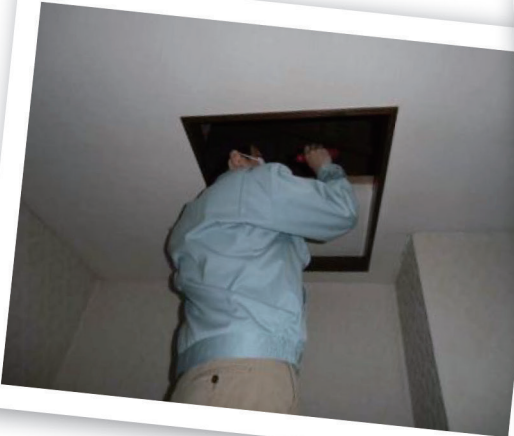
天井・小屋組み
