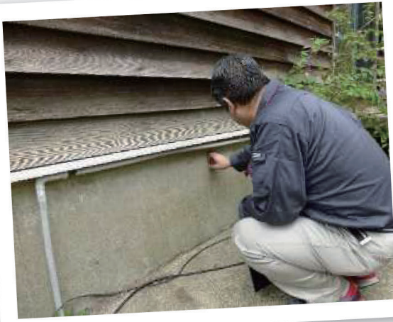
基礎（ひび割れ等）
