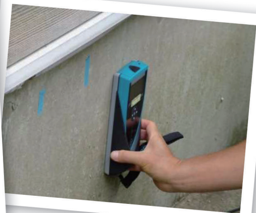
基礎（鉄筋探査）
